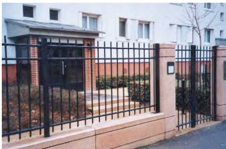
L'entrée de cet ensemble de logement a été restructurée avec un contrôle d'accès, pour prévenir le petit vandalisme et encourager un sentiment d'appropriation des habitants sur cet espace semi-privé © IAU île-de-France
