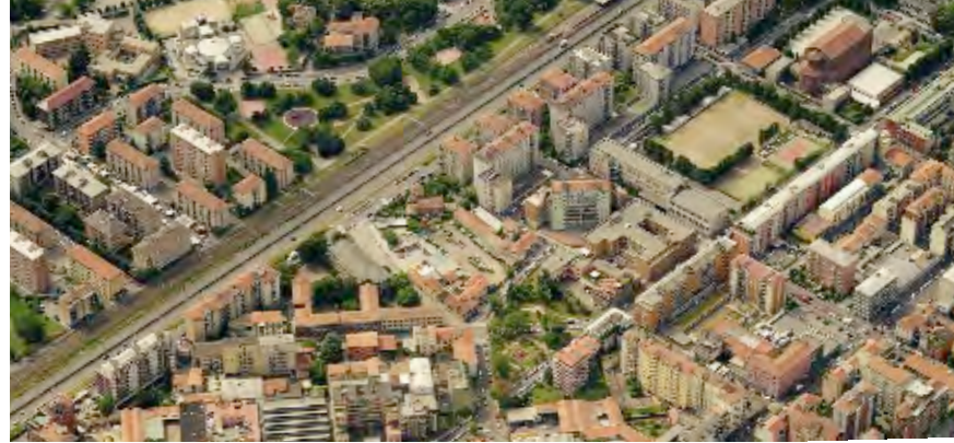
La ligne de métro combinée à une voie rapide crée une importante barrière physique qui divise le quartier
